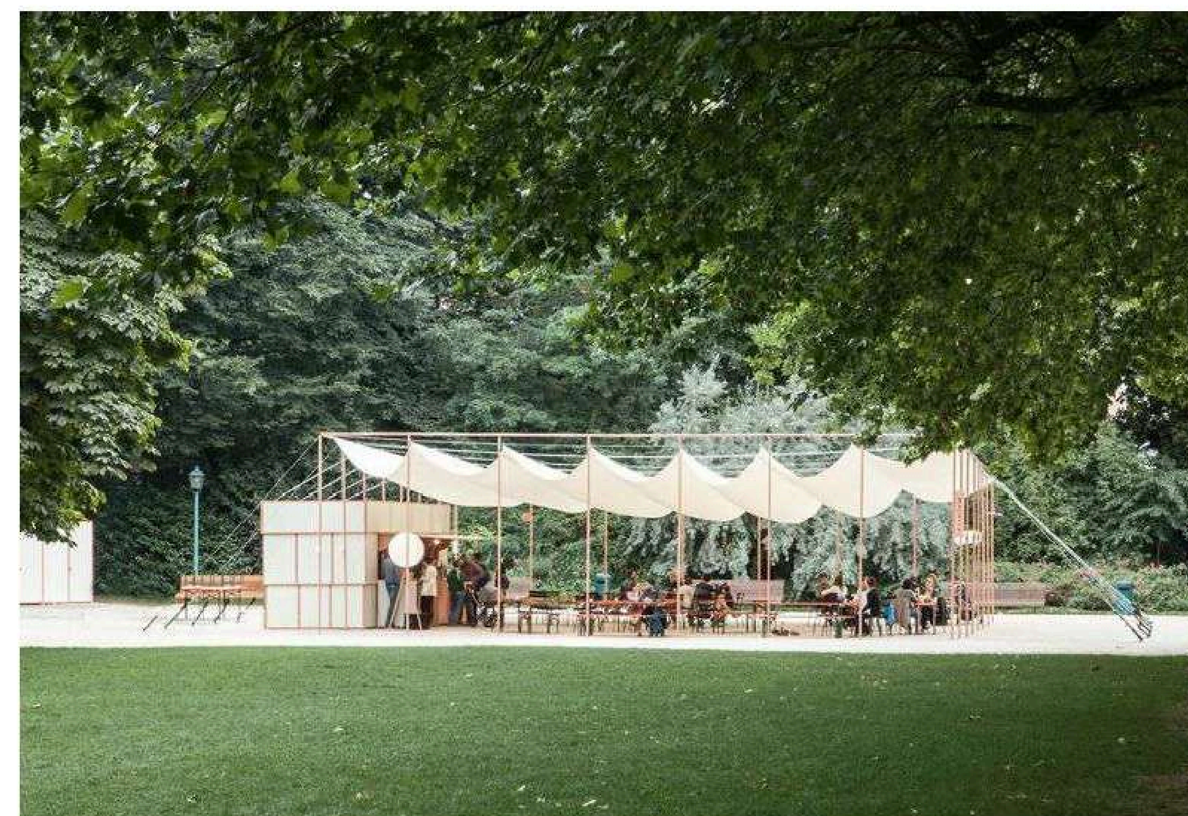
Dočasné tieniace konštrukcie pre akcie na nádvorí
